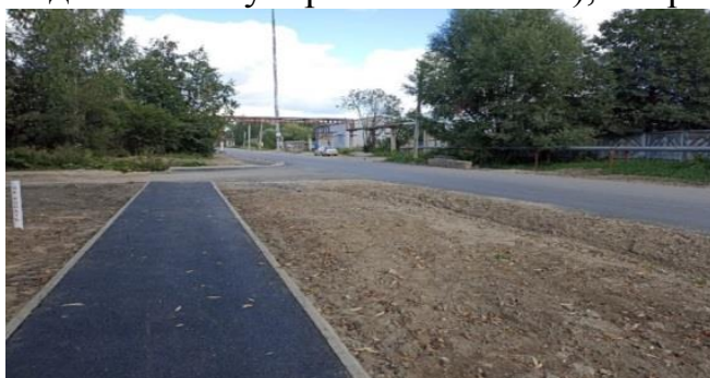
Ремонт ул. Изюмова в городе Соколе
