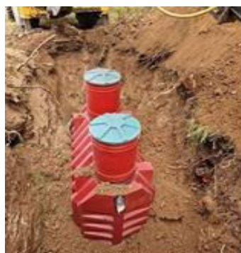
Устройство системы водопровода и канализации «Нестеровский ДК»
