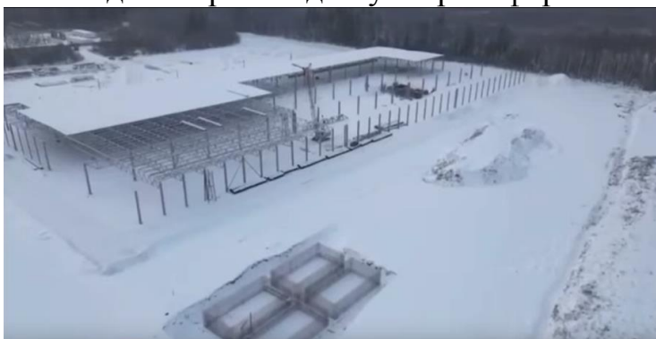
Строительство завода по производству широкоформатной фанеры (инвестор АО «Березник»)
