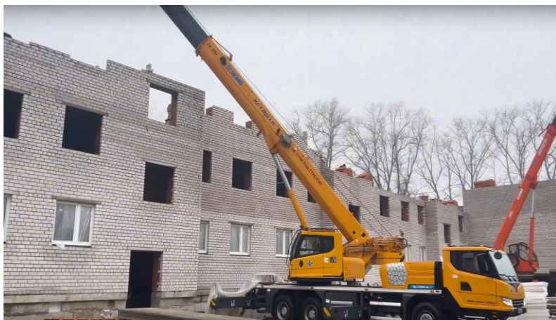
Строительство жилого дома (55 квартир) по ул. Советская
