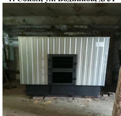
Приобретение и установка оборудования для котельной в д. Воробьево
