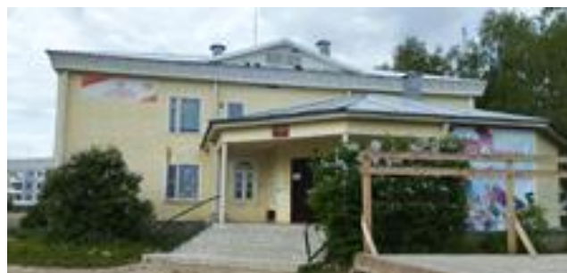
Биряковский ДК после ремонта
