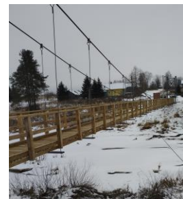
Капитальный ремонт моста через р. Двину
