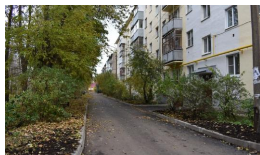
Ремонт дворов ул. Советская, д.46, д.48
