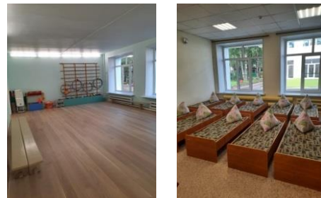
Капитальный ремонт внутренних помещений БДОУ СМР «Детский сад №5 «Березка»
